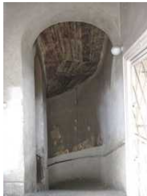
125.-127. A II. emeleti pihenő lépcsőházi ÉNy-i oldalfala a kosáríves árkádokkal– eredeti építéskori, műemléki értékű szerkezet és kialakítás
