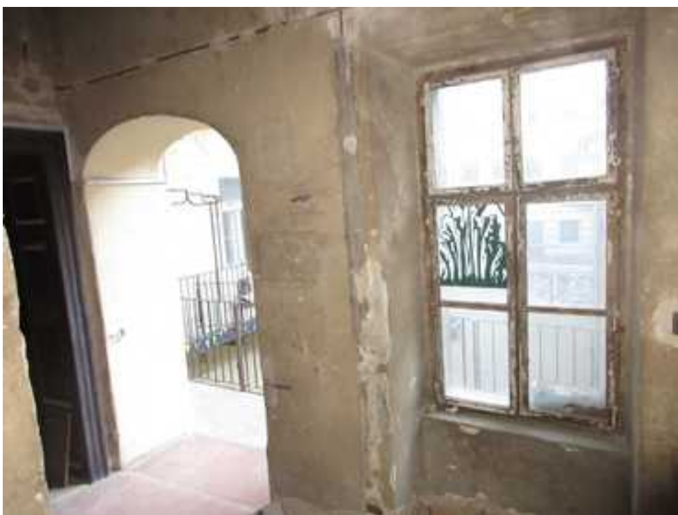
104. Az I. emeleti pihenő udvarral határos DK-i oldalfala a függőfolyosóra vezető kosáríves nyílással és egyenes záradékú ablaknyílással – eredeti építéskori, műemléki értékű szerkezet és kialakítás
