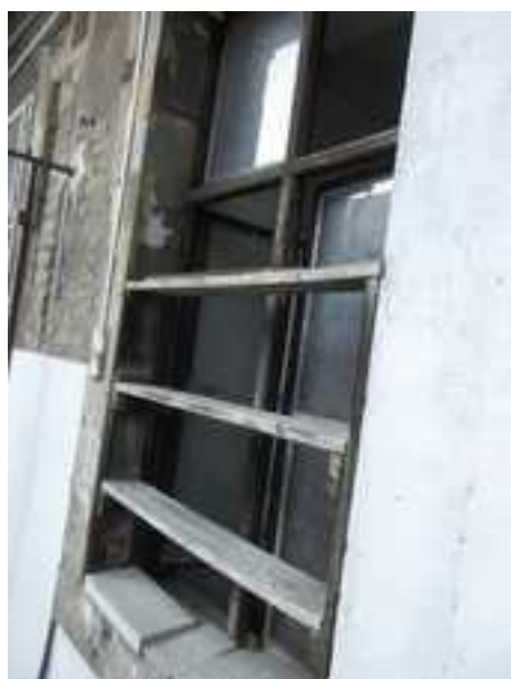
207.,208. A II. emeleti lépcsőházi ablak részlete - az ablak tokkerete még régi, de az ablakszárnyak és vasalatok már újak. Jól látható az ablaknyílás kőkerete
