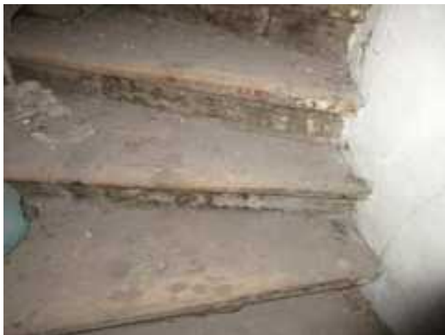
259.-262. A padlásra vezető lépcső nézetei és részlete, és a falazott oldalfal részlete – a faszerkezetű lépcső a 19. sz. közepe táján készült, műemléki értékű szerkezet
