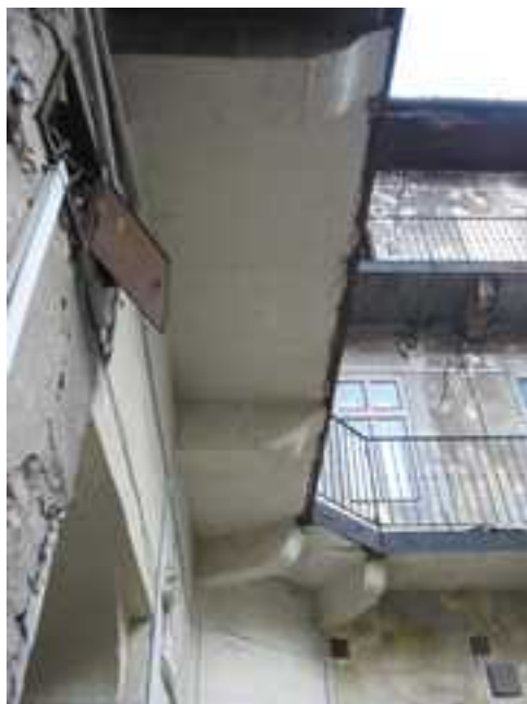
186.,187. Az I. emelet fölötti függőfolyosó nézetei – a kőkonzolok eredetiek, de a lemez már vasbetonból készült és néhány konzolt nem építettek vissza
