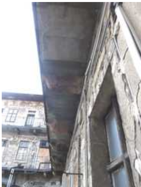
186.,187. Az I. emelet fölötti függőfolyosó nézetei – a kőkonzolok eredetiek, de a lemez már vasbetonból készült és néhány konzolt nem építettek vissza
