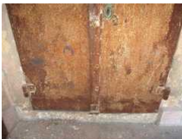
254.-258. A III. emeleti pihenőn elhelyezkedő padlásajtó nézete és részletei – a kétszárnyú fém ajtó 20. sz. első felében készült nyílászáró
