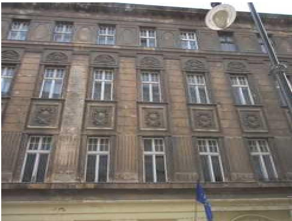
35.,36. Az utcai homlokzat emeleti szakaszának a kapualjtól balra (É-ra) eső nézetei – az épület eredeti klasszicista homlokzatát a 20. sz. elején egységesen a földszinttől a tetőig új szecessziós-historizáló vakolat-architektúrával díszítették. A szecessziós emeleti homlokzat és annak tagozatai (övpárkányok, főpárkány, szecessziós vakolati díszek), a nyíláskiosztások és a bennük lévő szecessziós megjelenésű ablakok nyílászárói műemléki értékű elemek
