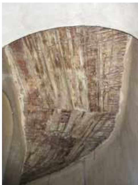
119.,120. A szürke mészkő szerkezetű lépcső részlete a kitöréssel és a lépcsőkar sérült mennyezetének a nézete – a lépcső eredeti építéskori szerkezet
