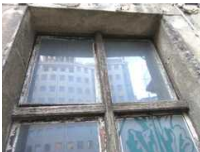
190.-192. Az I. emeleti lépcsőházi ablak nézete és részletei – a kőkeretben elhelyezkedő ablaknyílás és a benne lévő egyrétegű nyílászáró még korabeli, műemléki értékű szerkezet
