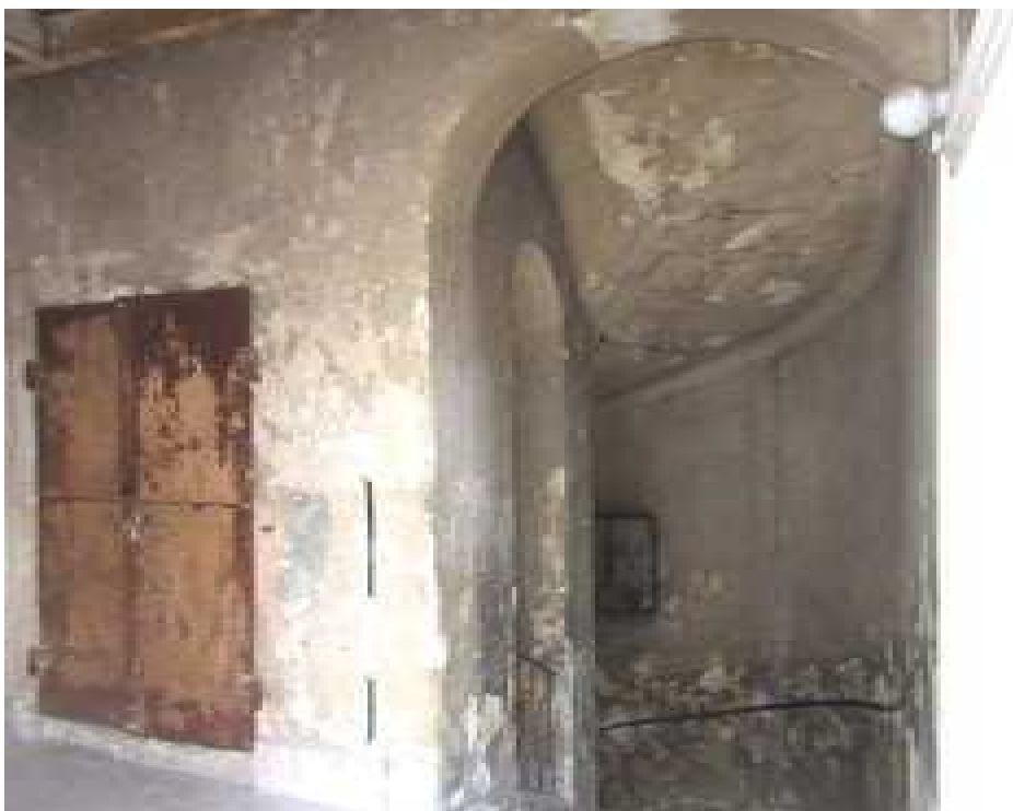
153. A III. emeleti pihenő ÉNy-i oldalfala a padlásra vezető ajtóval és a lépcső érkezési árkádjával - a III. emeleti pihenő a 19. sz. közepe táján épült, műemléki értékű szerkezet és kialakítás. A fém padlásajtó 20. sz. eleji szerkezet
