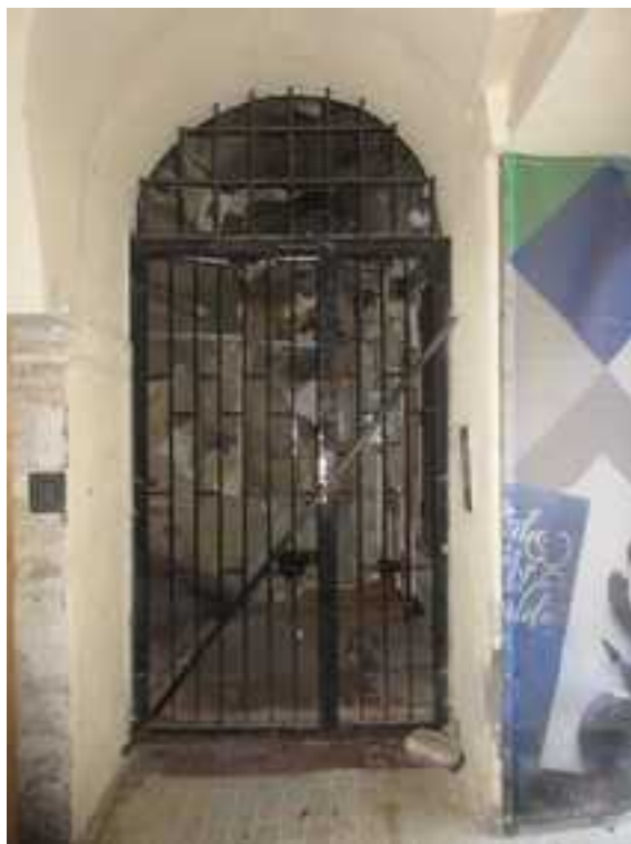
75. A kapualj bal oldalának udvar felé eső végén lévő lépcsőházi nyílás – a félköríves záradékú nyílás építéskori és a lépcsőház földszinti előterébe vezet. Az igénytelen rács újabb szerkezet
