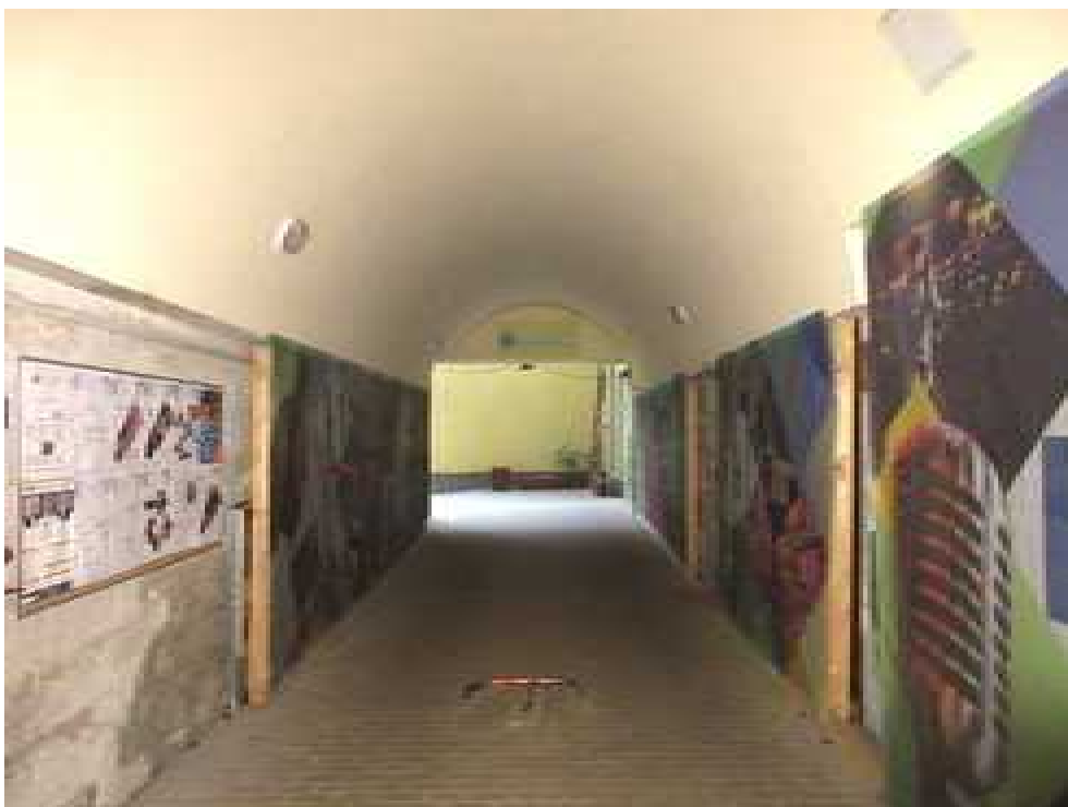
66.,68. A kapualj nézete az utca és az udvar felé - a kapualj oldalfalait molinók takarják, a földémet pedig egy dongaboltozatot imitáló doboz-szerű burkolat alkotja. A kapualj földémét eltakaró burkolat alatt minden bizonnyal még meg van az archív terveken ábrázolt eredeti építéskori, hevederekkel tagolt csehsüveg boltozatos földém. a boltozattal fedett kapualj kialakítása és szerkezete 1812-ben készült, műemléki értékű szerkezet
