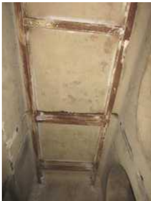
102.,103. Az I. emeleti pihenő födémének és vörös-mészkő burkolatos járófelületének a nézetei – a síkfödém építéskori, de az acélkeretes megerősítés az 1960-as években készült. A nagyméretű elemekből álló vörös-mészkő burkolat építéskori
