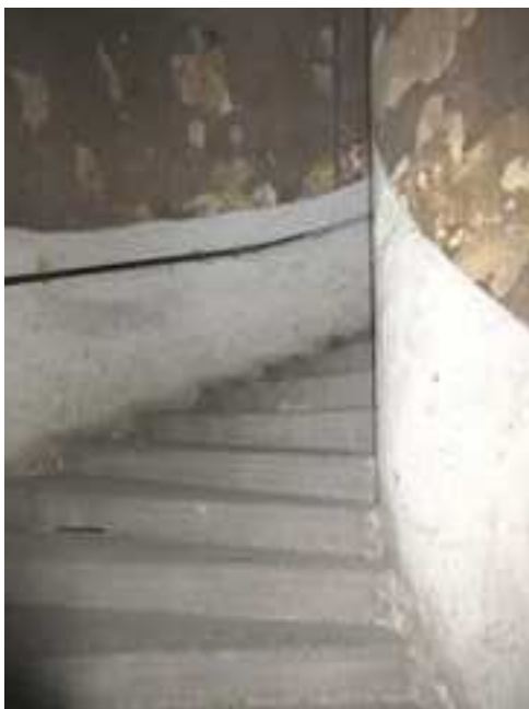
115.,116. Az I. emeletről a II. emeletre haladó lépcsőkar középső íves részlete és a lépcső alsó síkjáról hiányzó vakolat - a szürke mészkő lépcsőfokokból épített lépcsőkar eredeti építéskori, műemléki értékű szerkezet
