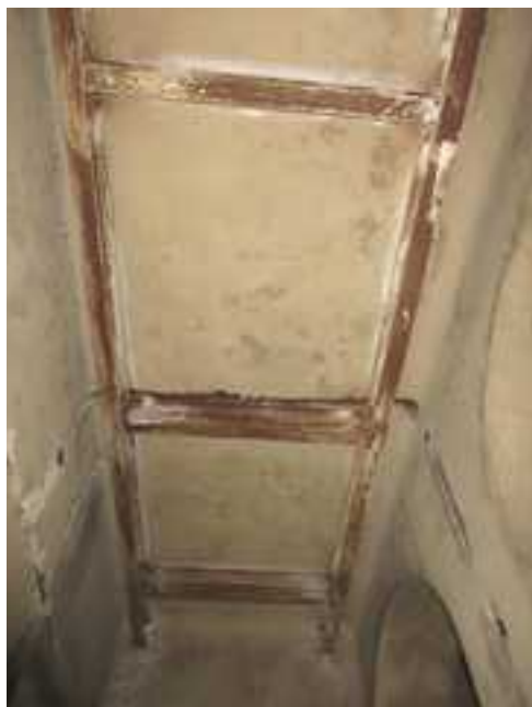
102.,103. Az I. emeleti pihenő födémének és vörös-mészkeő burkolatos járófelületének a nézetei – a síkfödém építéskori, de az acélkeretes megerősítés az 1960-as években készült. A nagyméretű elemekből álló vörös-mészkeő burkolat építéskori
