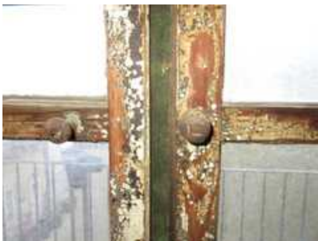
105.-109. Az I. emeleti lépcsőházi abéak nézetei és részletei – a 2 x 3 szemes egyrétegű, korabeli vasalatokkal rendelkező faablak eredeti építéskori, műemléki értékű nyílászáró
