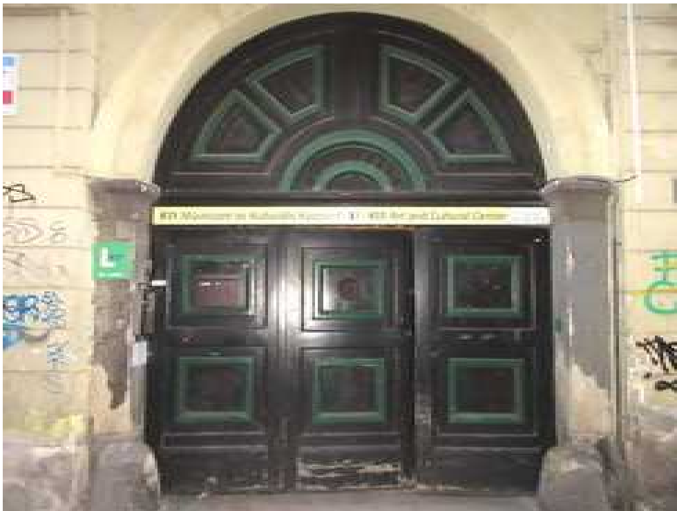
23.,24. A homlokzat középtengelyében elhelyezkedő bejárati kapu nézetei – a félköríves záródású, két kerékvetővel kialakított kapuzat eredeti építéskori, klasszicista szerkezet, műemléki érték. A félköríves záradéku, felülvilágító, vésett betétes kétszárnyú bejárati kapu asztalos-szerkezete és vasalatai 1958-ban készült. Bár a kapu nem eredeti építéskori, de klasszicizáló megjelenésével és igényes kialakításával történeti értékű nyílászáró
