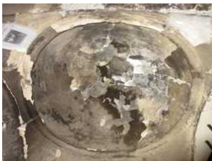
82.-83. A földszinti lépcsőházi előtér padlóburkolata és mennyezetének nézete – a nagyméretű vörös-mészkő járófelület és a köríves stukkótagozattal díszített csehsüveg boltozatos mennyezet eredeti építéskori, műemléki szerkezetű elemek
