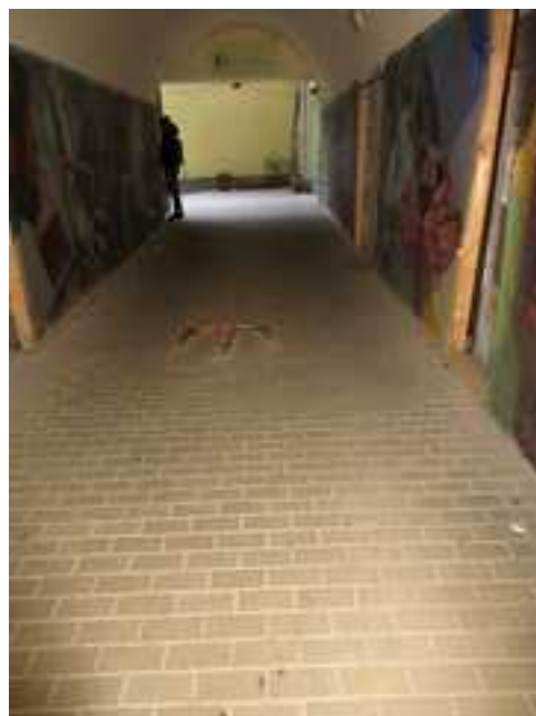
76.,77. A kapualj boltozatának és padlóburkolatának a nézete – a kapualj eredeti földémét eltakaró dongaboltozatos áll-burkolat utólagos, zavaró és megtévesztő megoldás. A jelenlegi sárgás térkő burkolat sem eredeti, 2010 után készült, nem túl igényes burkolat
