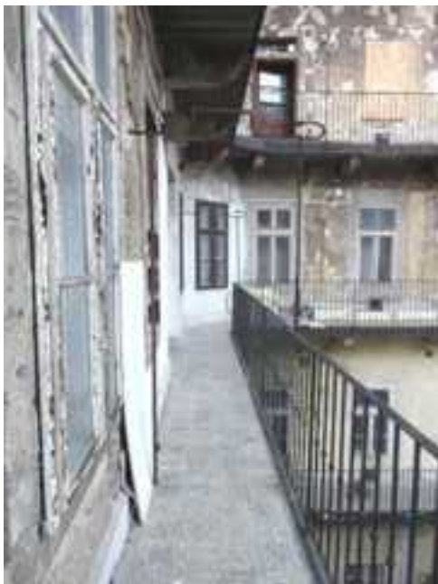
195.-198. A II. emeleti függőfolyosó és a fölötté lévő konzolos függőfolyosó nézetei DNy és ÉK felé – a vasbeton lemezes függőfolyosón szürke cementlap burkolat van, az eredeti vörös-mészkő lemez cseréje az 1960-as évek végén történt, ekkor az eredeti kőkonzolokat csak részben helyezték vissza
