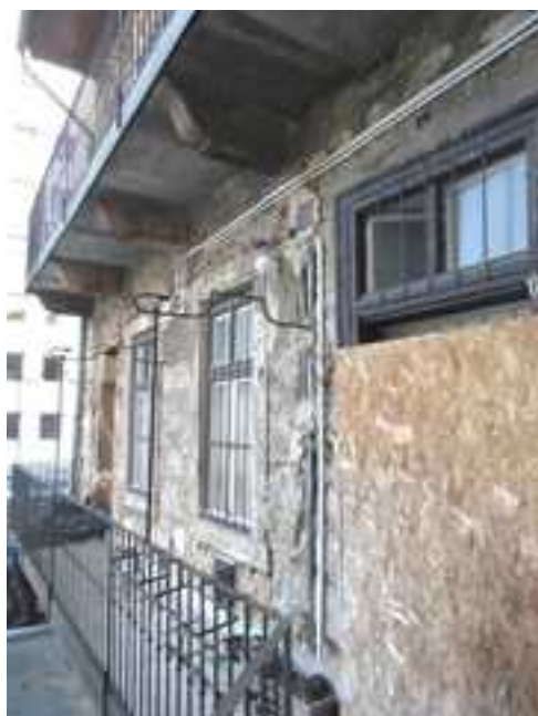
225.-227. A DNy-i oldalszárny II. emeleti szakaszának homlokzati nézete és részletei, valamint az egykori közös illemhely bejárata – a homlokzati nyíláskiosztások nagy része és a függőfolyosó kovácsoltvas pálcarácsos korlátja eredeti építéskori, 1812-ben épült műemléki értékű szerkezetek. A kétrétegű, befelé nyíló ablakok új, igénytelen nyílászárók, a függőfolyosó vb. szerkezetű
