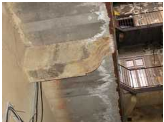
177.-181. Földszinti ablakok és ajtó részlete, pince lejárata és az I. emeleti függőfolyosó alulnézetei – az ablaknyílás és a felülvilágító körkeretes ajtónyílás új, nem eredeti. A pincelejárata utólagos, a függőfolyosó kőkonzolja építéskori, de a vb. lemez új
