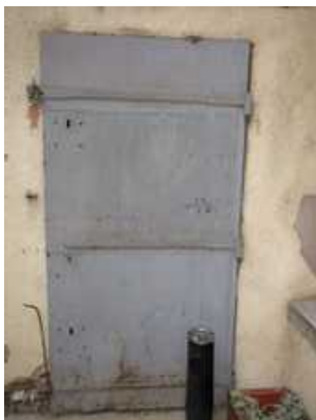
172.-176. Az udvari szárny földszinti szakaszának nézete és részletei – a földszinti homlokzat szerkezeti falai építéskoriak, 1812-ben készültek. A nyíláskiosztások és a bennük lévő nyílászárók (ablakok, fém raktár-ajtó) nem építéskoriak. A fém ajtó helyén nyílt egykor a pincelejárát
