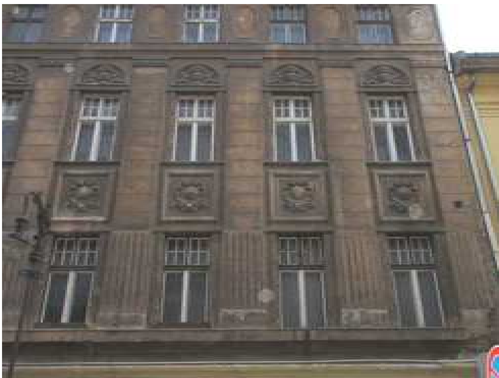
37.,38. Az utcai homlokzat emeleti szakaszának a kapualjtól jobbra (Ny-ra) eső nézetei - a szecessziós emeleti homlokzat és annak tagozatai (övpárkányok, főpárkány, szecessziós vakolati díszek), a nyíláskiosztások és a bennük lévő szecessziós megjelenésű ablakok nyílászárói műemléki értékű elemek
