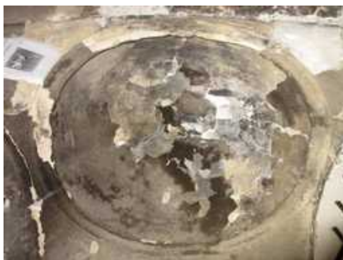
82.-83. A földszinti lépcsőházi előtér padlóburkolata és mennyezetének nézete – a nagyméretű vörös-mészke járófelület és a köríves stukkótagozattal díszített csehsüveg boltozatos mennyezet eredeti építéskori, műemléki szerkezetű elemek
