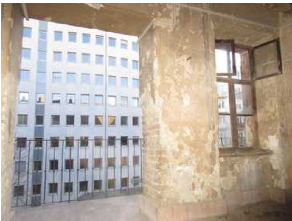
154. A III. emeleti lépcsőházi pihenő udvarral határos DK-i oldalfala a függőfolyosóra vezető egyenes záradékú ajtónyílással és ablakkal – a III. emeleti pihenő a 19. sz. közepe táján épült, műemléki értékű szerkezet és kialakítás. Az ablak tokkerete még korabeli, de az ablakszárnyak már újabbak
