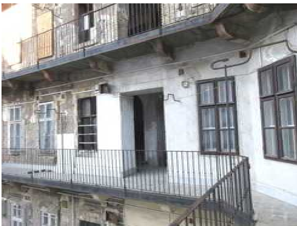
193., 194. A Király utcai szárny II. emeleti szakaszának homlokzati nézetei – a homlokzati nyíláskiosztások nagy része és a függőfolyosó kovácsoltvas pálcarácsos korlátja eredeti építéskori, 1812-ben épült műemléki értékű szerkezetek. Itt még vannak ablakok kétrétegű, ki-be nyíló, klasszicista szerkezetű korabeli nyílászárókkal. Eredeti bejárati ajtó nincs. Az egyrétegű lépcsőházi ablaknak csak a tokja építéskori
