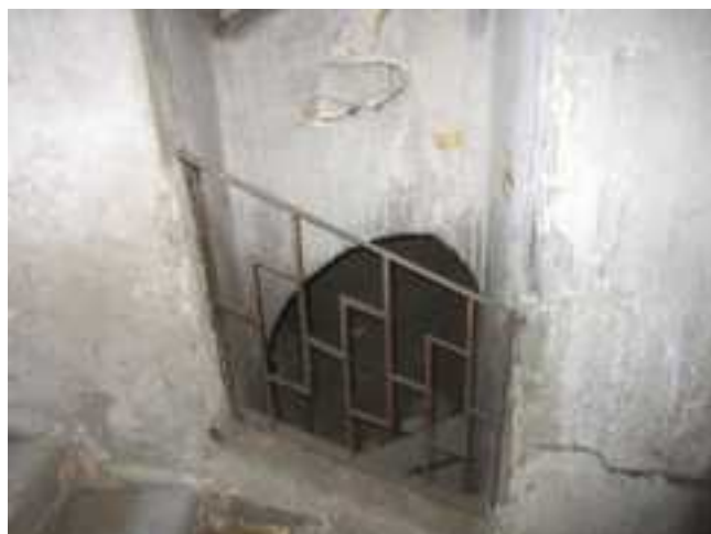
121.-124. Az I. emeletről a II. emeletre haladó lépcsőkar felső, a II. emeleti pihenőre érkező részlete, valamint az íves nyílásokkal áttört orsótér nézetei - a szürke mészkő lépcsőfokokból épített lépcsőkar és orsótér eredeti építéskori, műemléki értékű szerkezetek. Az orsótér nyílásaiban lévő jelenlegi fém korlát újabb szerkezet
