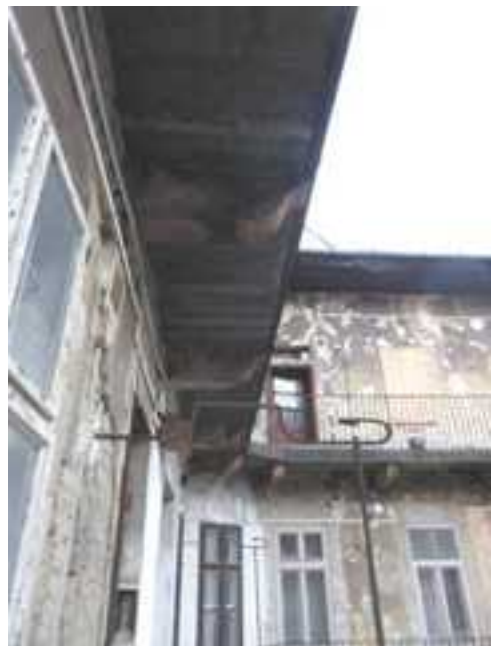
195.-198. A II. emeleti függőfolyosó és a fölötté lévő konzolos függőfolyosó nézetei DNy és ÉK felé – a vasbeton lemezes függőfolyosón szürke cementlap burkolat van, az eredeti vörös-mészkő lemez cseréje az 1960-as évek végén történt, ekkor az eredeti kőkonzolokat csak részben helyezték vissza
