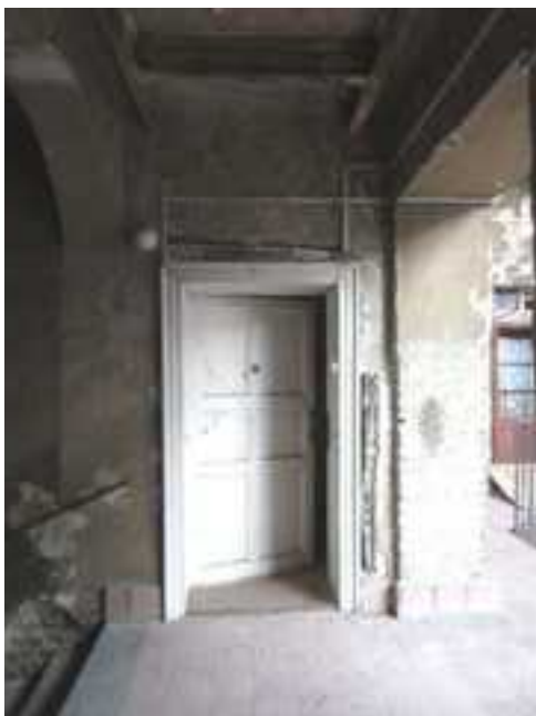
159.,160. A III. emeleti lépcsőházi pihenő ÉK-i és DNy-i oldalfalának nézete és a lakásbejárati ajtókkal – a pihenő szerkezeti kialakítása a 19. sz. közepe tájáról való, műemléki értékű szerkezet. Az ÉK-i ajtó új nyílászáró, a DNy-i ajtó hiányzik
