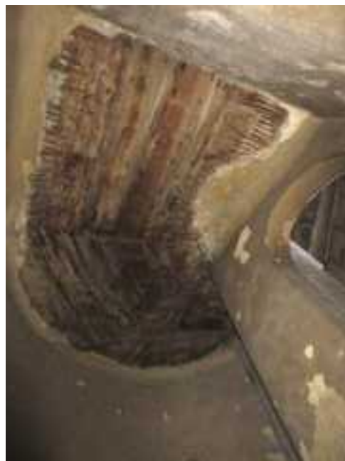
115.,116. Az I. emeletről a II. emeletre haladó lépcsőkar középső íves részlete és a lépcső alsó síkjáról hiányzó vakolat - a szürke mészkő lépcsőfokokból épített lépcsőkar eredeti építéskori, műemléki értékű szerkezet
