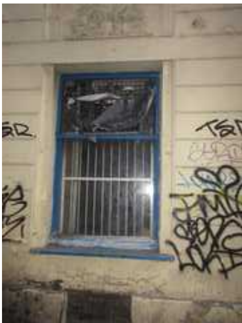
30. -34. A bejárat kapu kerékvetőinek részlete, pinceablak és földszinti boltablak és ajtó nézete – a kő kerékvetők építéskori szerkezetek, a pinceablak nyílása építéskori, a rács új. A földszinti nyílásokat az eredeti klasszicista nyíláskiosztás szerint állították vissza 1957-ben, a bennük lévő nyílászárók is akkor készültek
