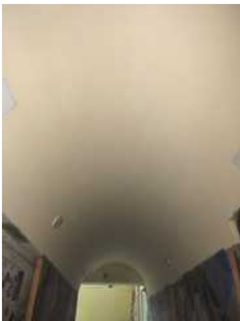
76.,77. A kapualj boltozatának és padlóburkolatának a nézete – a kapualj eredeti földémét eltakaró dongaboltozatos áll-burkolat utólagos, zavaró és megtévesztő megoldás. A jelenlegi sárgás térkő burkolat sem eredeti, 2010 után készült, nem túl igényes burkolat
