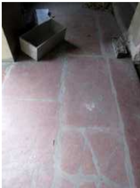
102.,103. Az I. emeleti pihenő födémének és vörös-mészkő burkolatos járófelületének a nézetei – a síkfödém építéskori, de az acélkeretes megerősítés az 1960-as években készült. A nagyméretű elemekből álló vörös-mészkő burkolat építéskori
